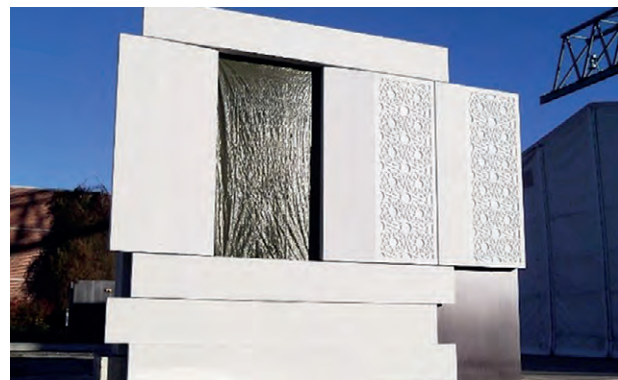
Abbildung 3: Beispiele für Erprobungsbauteile – links: Wand, Quelle: nbw Neustädter Betonwerk GmbH; rechts: Fassade, Quelle: GBJ Geithner Betonmanufaktur Joachimsthal GmbH
